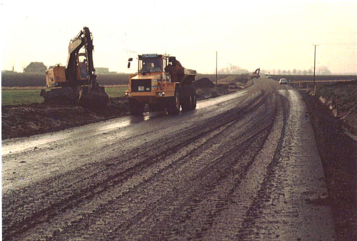
Figur 4.5 Foto nedsmutsning vid justering av vägslänter
