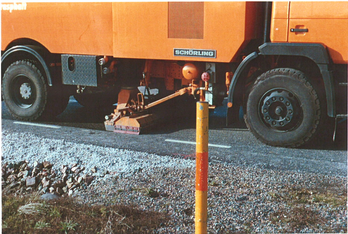
Figur 5.3 Försök med rensning av igensatt dränerande asfalt på Borrebackevägen. Utrustning från Schörling.
