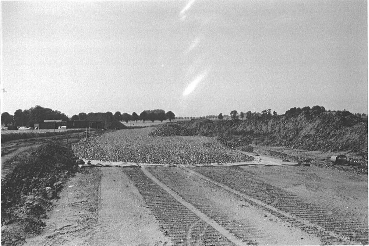
Figur 4.1 Foto från utläggningen av makadam på Borrebackevägen.
