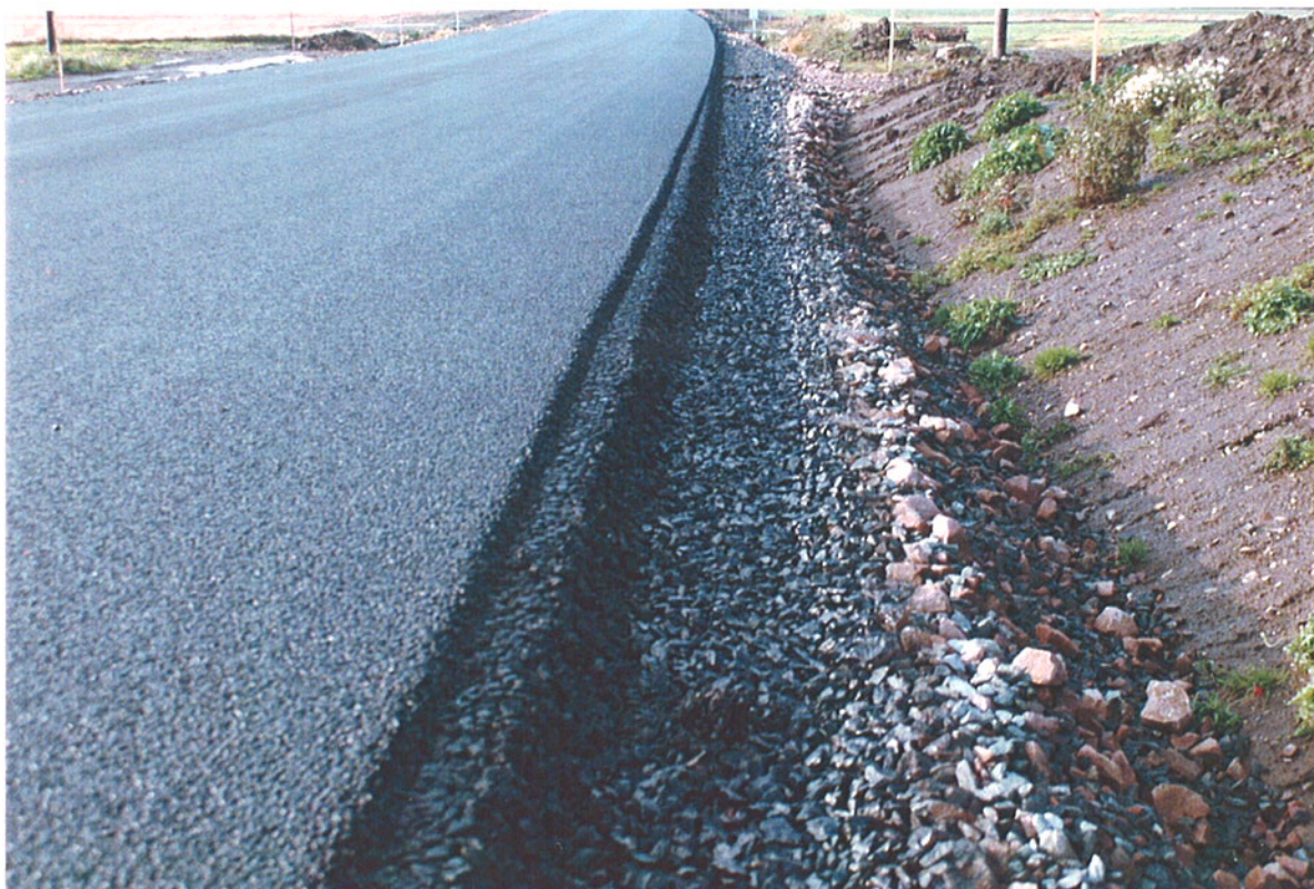
Figur 4.4 Färdig Viacodrän före justering av vägslänter.
