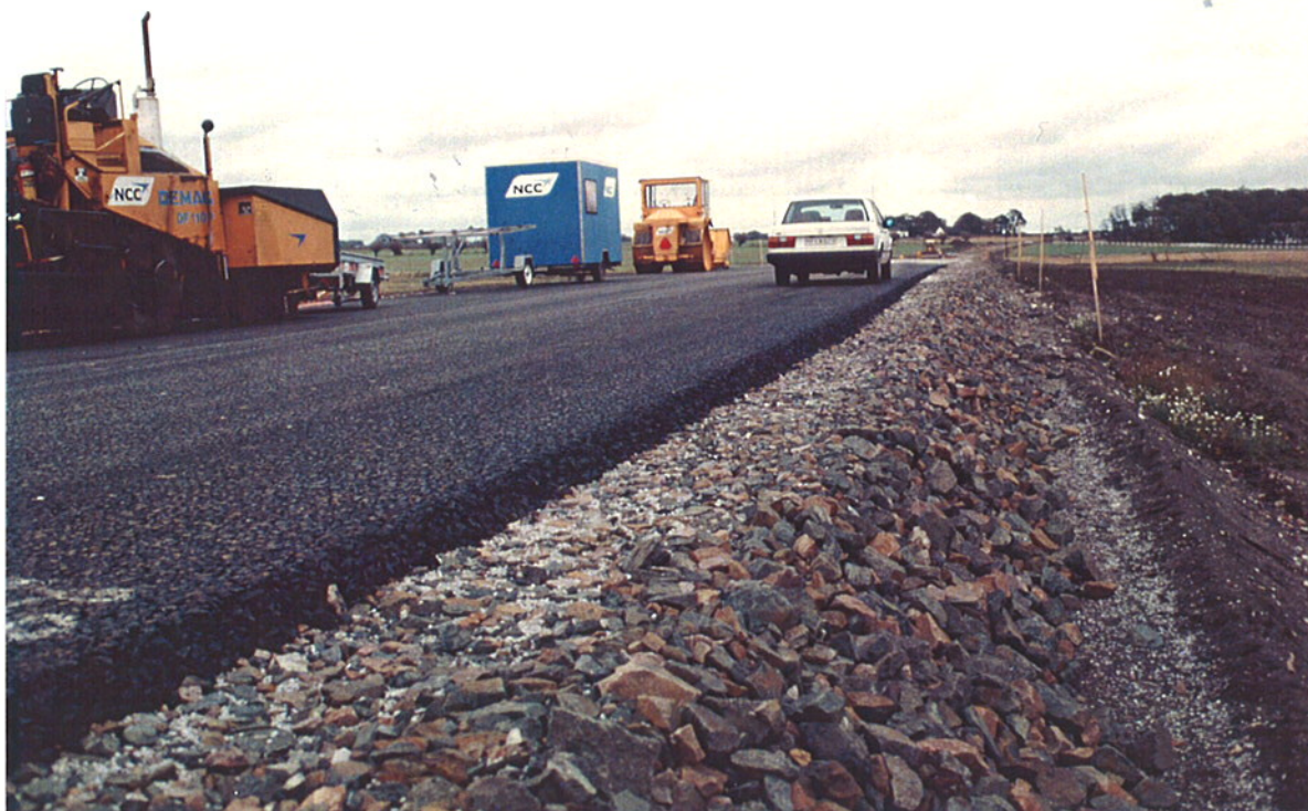
Figur 4.3 Färdig Viacobase på makadambärlager (med bodar).
